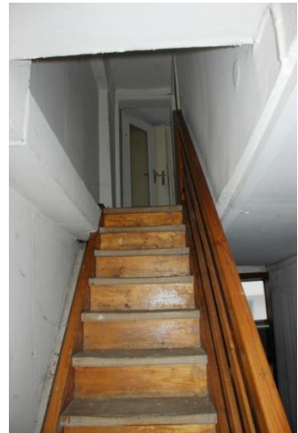
(25) Treppe zum DG
